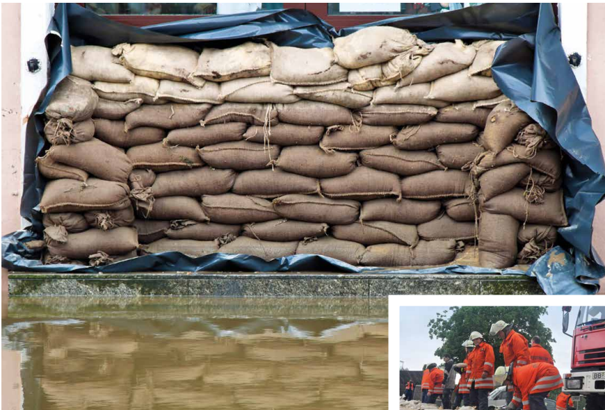
Schutzwälle aus Sandsäcken
